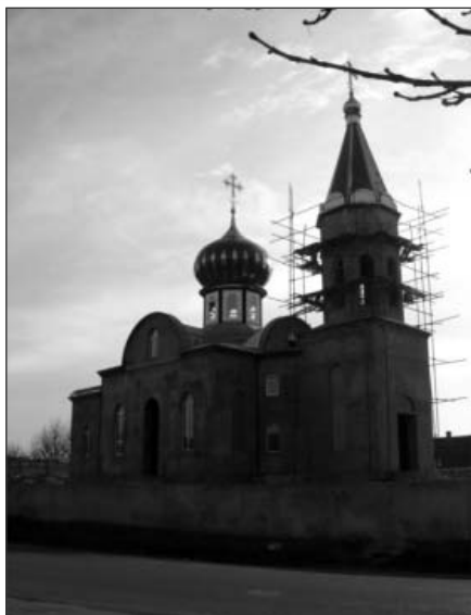
Рис. 9. Строящаяся церковь Архангела Михаила
